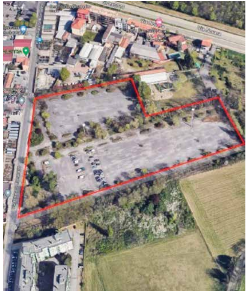
Veduta dell'area di via San Romanello
